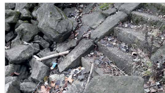
V líniách kamenného opevnenia v záujmovom území vzniklo na brehu niekoľko „nátrží“, ktoré sú stabilné, sú žiaducim prírodným prvkom a budú základom a vzorom pre technickú revitalizáciu brehu do prírody blízkej podoby na vybraných miestach. Opevnenie pri vode a jeho zviazanie na okrajoch bude upravené do prírody blízkej podoby umožňujúcej príjemný pobyt a pohodlný prístup k vode. Príklad je zo Starého hája.
