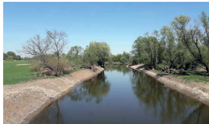
Obr. 36. Vtok do Starohájskeho ramena, aj do Jarovského ramena bude obnovený vykopaním nového prepojenia s dĺžkou cca 200 m, s podobným vzhľadom ako tento príklad obnovy bočného ramena z rieky Morava pri Marchegg.
