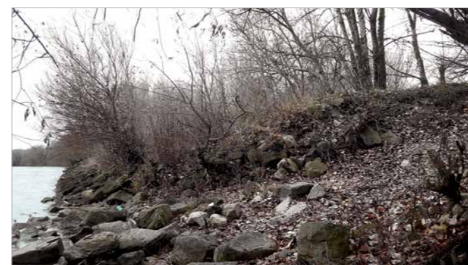
V líniách kamenného opevnenia v záujmovom území vzniklo na brehu niekoľko „nátrží“, ktoré sú stabilné, sú žiaducim prírodným prvkom a budú základom a vzorom pre technickú revitalizáciu brehu do prírody blízkej podoby na vybraných miestach. Opevnenie pri vode a jeho zviazanie na okrajoch bude upravené do prírody blízkej podoby umožňujúcej príjemný pobyt a pohodlný prístup k vode. Príklad je zo Starého hája.
