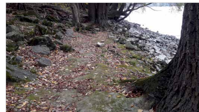
Staré kamenné opevnenie v Pečnianskom lese je funkčné a stabilné a už na ňom do istej miery prebehli žiaduce procesy renaturácie. Breh na vybraných odpočinkových a vyhliadkových miestach bude jednoducho upravený do podoby umožňujúcej príjemný vstup do vody.
