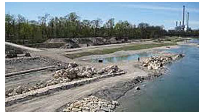
Budovanie prírode blízkeho opevnenia brehu na rieke Isar v Mníchove (zdroj: Isarplan)
